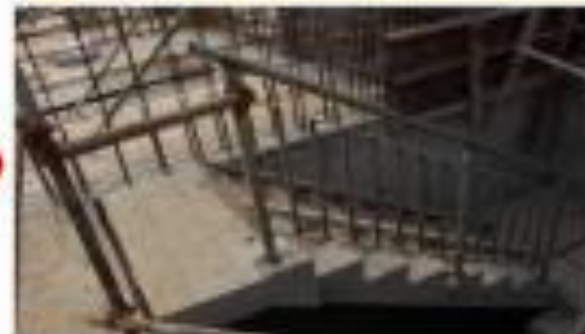
楼梯构件安装完成
