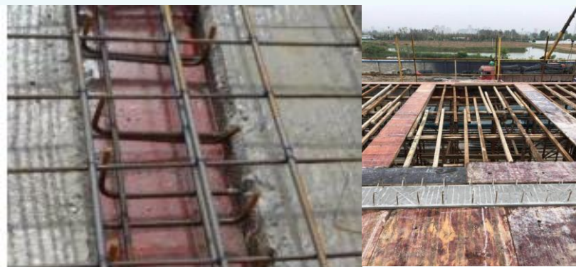
双向板接缝处理
