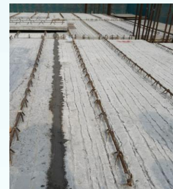
单向板密缝坐浆处理
